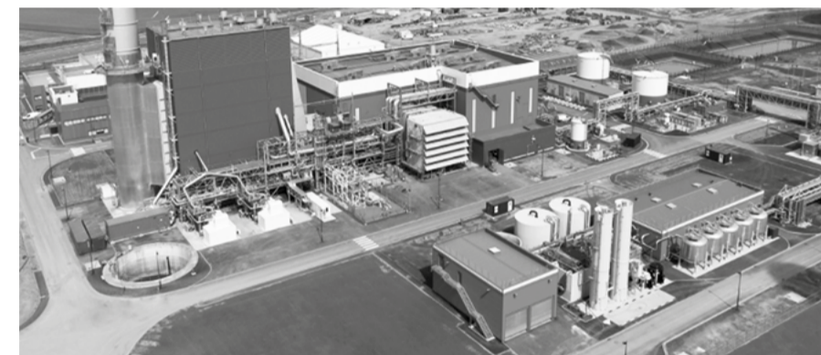
Central de Ciclo Combinado de Bouchain
