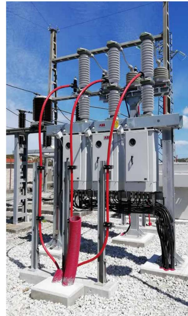
Avanzan a buen ritmo las obras para la **Ampliación de la Subestación Eléctrica 20/66kV del Parque Eólico de Corme** (18,3MW) para EDPR en Galicia. La obra consiste en la renovación de todo el sistema de 20 kV existente (incluyendo el montaje de una nueva batería de condensadores de 20 kV y el aparellaje de interperie asociado a la misma), el suministro y montaje del nuevo sistema de control y protección de la subestación, así como la obra civil asociada a dichos trabajos. La finali-
