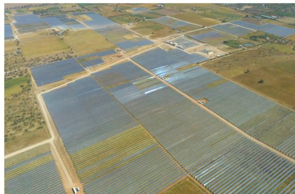
La planta solar Horus, ubicada en la región de Aguascalientes, en el centro de México, tiene una potencia instalada de 118,74 MWp, que se consigue con una configuración de 297.105 paneles solares, 3.562 seguidores monofila y
